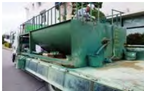
吹付工用ポンプ車
