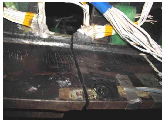
写真-4 フランジ切断
