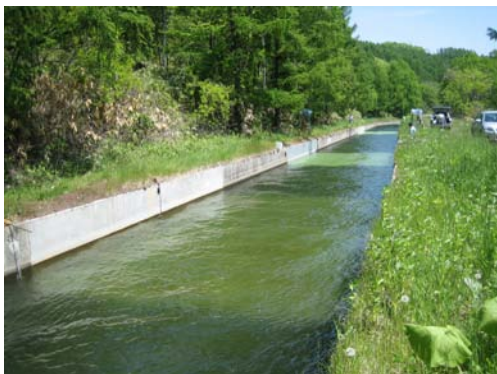
試験施工区間の状況(施工後)
