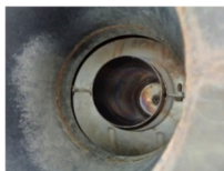
図-16 二重構造の排気管の例
