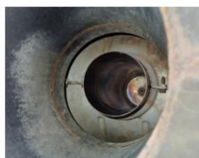
図-2.7 二重構造の排気管の例.
