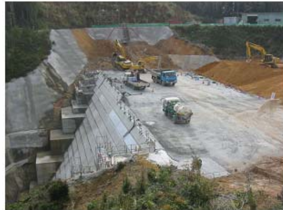
写真-1 大保ダム沢処理工
