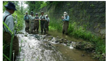
帯工的に設置して 瀬淵を形成した事例
