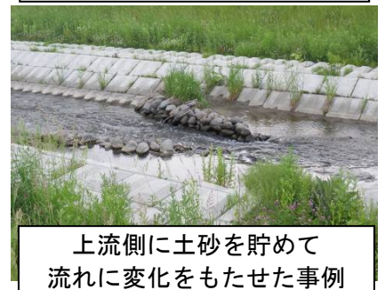
帯工的に設置して 瀬淵を形成した事例
