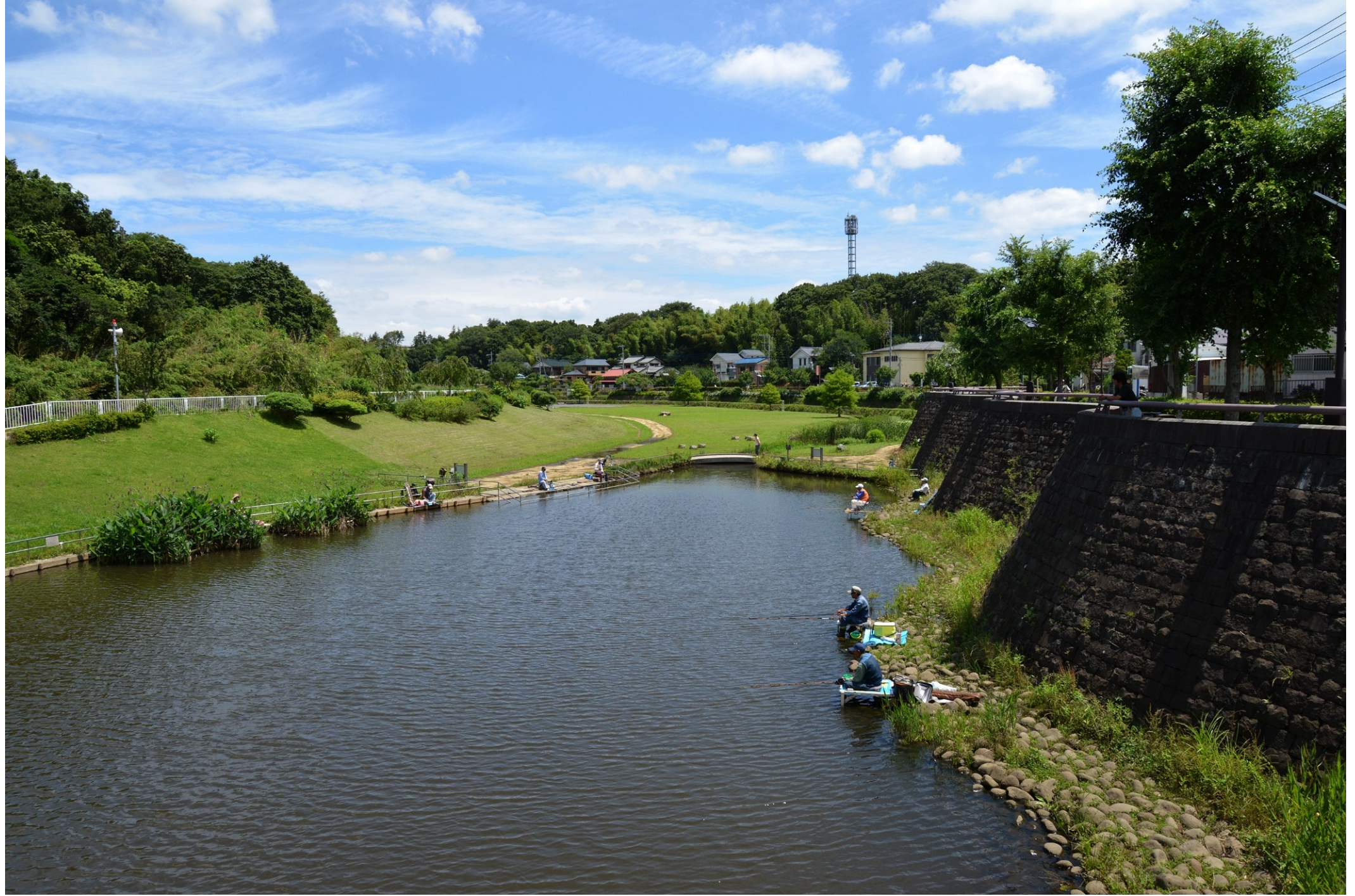
石積護岸(和泉川・宮沢遊水地)
