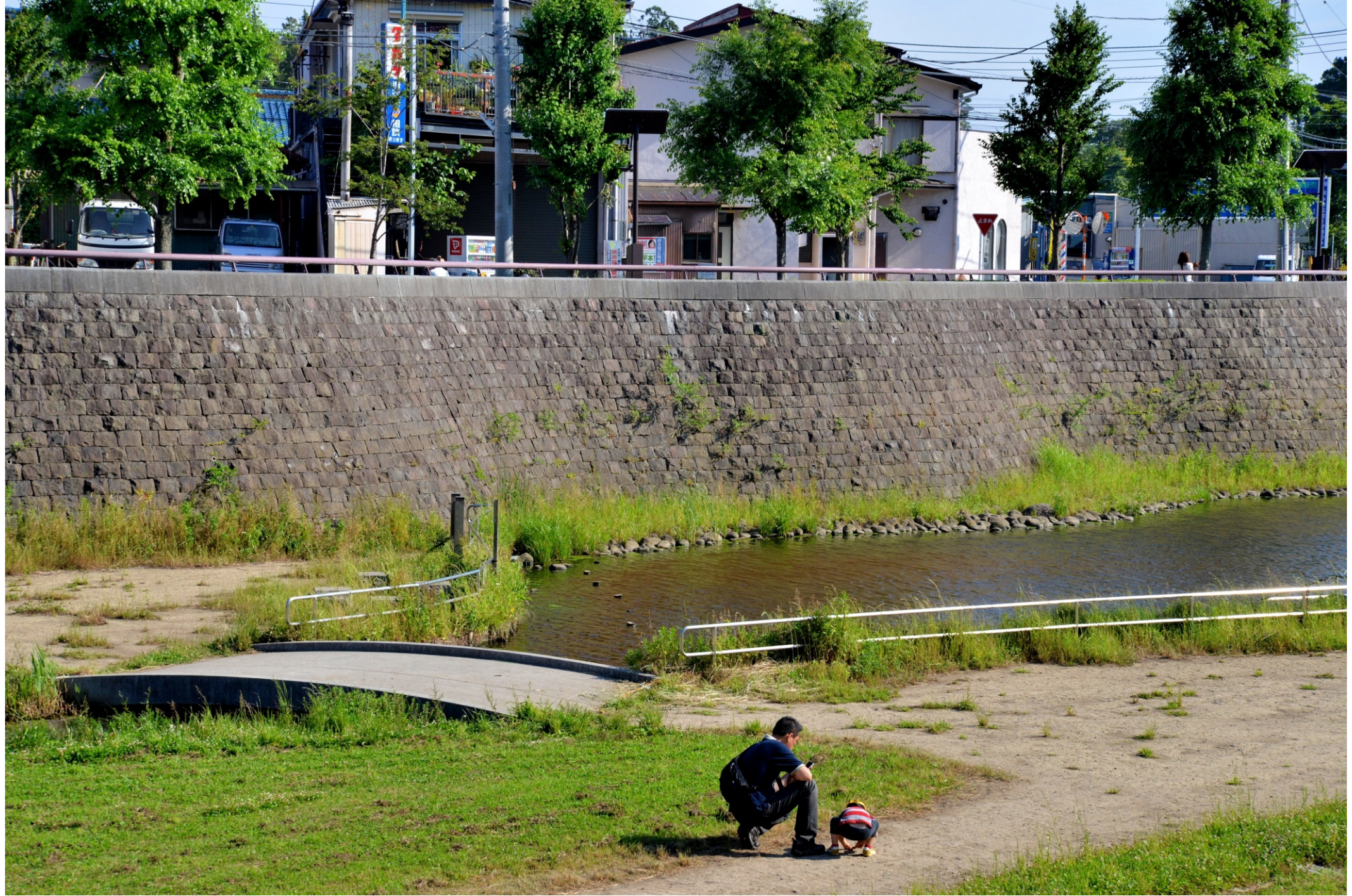
石積護岸(和泉川・宮沢遊水地)
