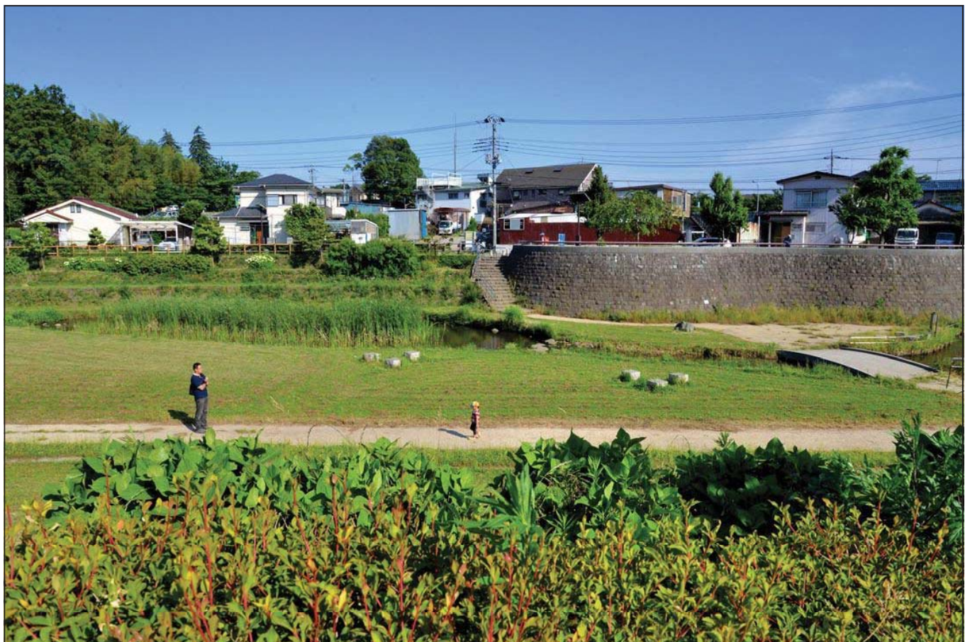
和泉川宮沢遊水地(横浜市) 三段の石積と1段の石積(テラス)
