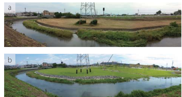
写真2 公園と河川の一体整備全景(写真 岐阜県提供) (a) 施工前 (b) 施工後
