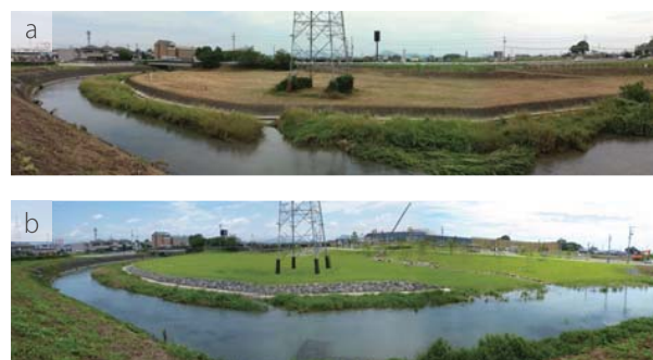
写真2 公園と河川の一体整備全景(写真 岐阜県提供) (a) 施工前 (b) 施工後
