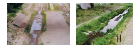
復元工法実施前の写真 復元工法実施後の写真
