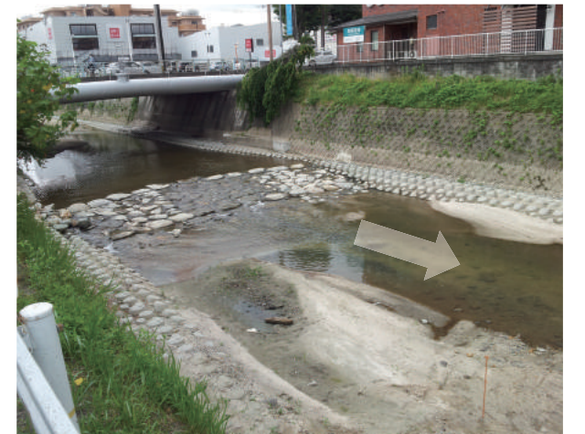
写真2 施工後の早瀬工の状況
