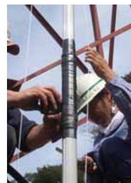
保護テープの巻きつけ状況
