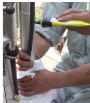
コーキング材の塗布状況
