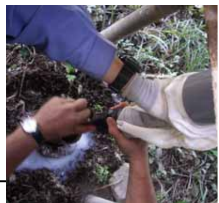
ガイド管の下端は、挿入開始時にテープで固定する(忘れないように)
