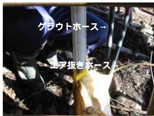
ガイド管挿入後の孔口の状況
