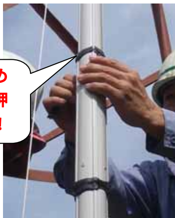
止水材の巻きつけ状況
