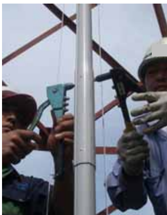
リベットの打設状況
