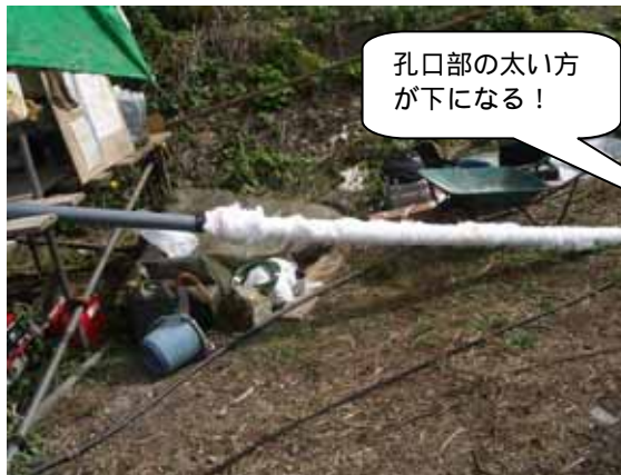
塩ビ管に被せたパッカー(写真は80m分)
