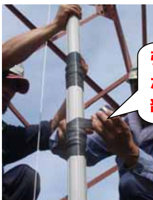
ブチルゴムテープの巻きつけ状況
