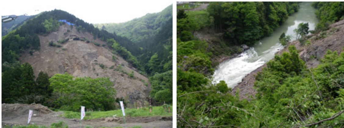
写真-1 地すべり地全景 (H18. 5. 14 撮影)
