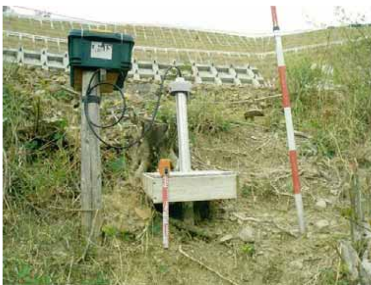
写真-3-1-1-2 孔内傾斜計ガイドパイプの浮き上がり例（静岡県滝沢地区）
