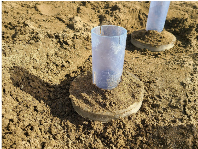
(6) -4: 土砂充填完了時の状況 ・ 止水材の押し固め完了後に、止水材上部の外円筒内側に土砂を充填する ・ 土砂は外円筒より上側に盛り上がり上がっても良いが、地盤の透水性が低い場合は目盛を用いて目視で水位を計測する必要があるため、透水性が低いと予想される場合には目盛が判読可能となる程度の高さに抑えることが望ましい
