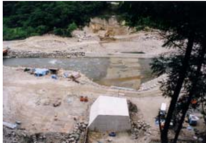
CSG 施工状況
