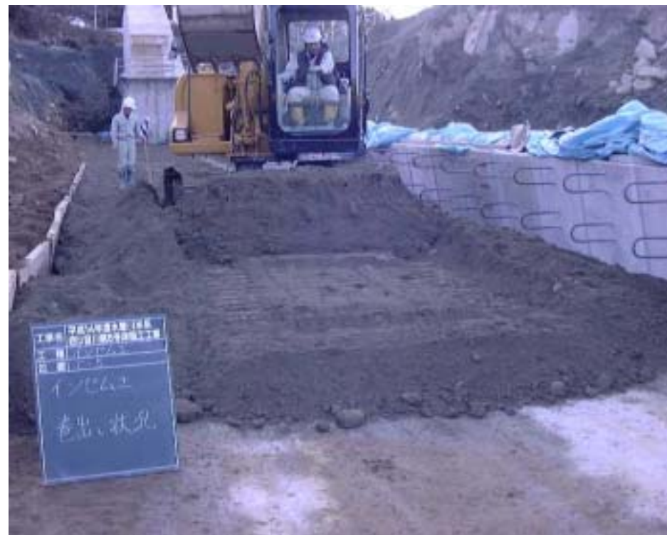
敷均し作業状況
