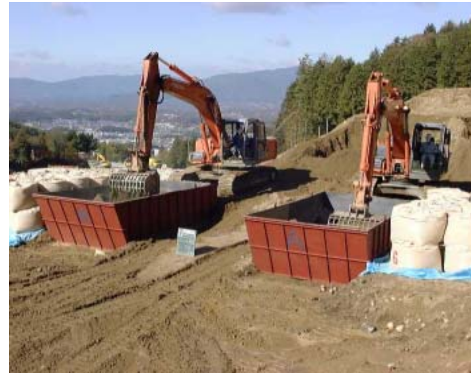
混合作業状況
