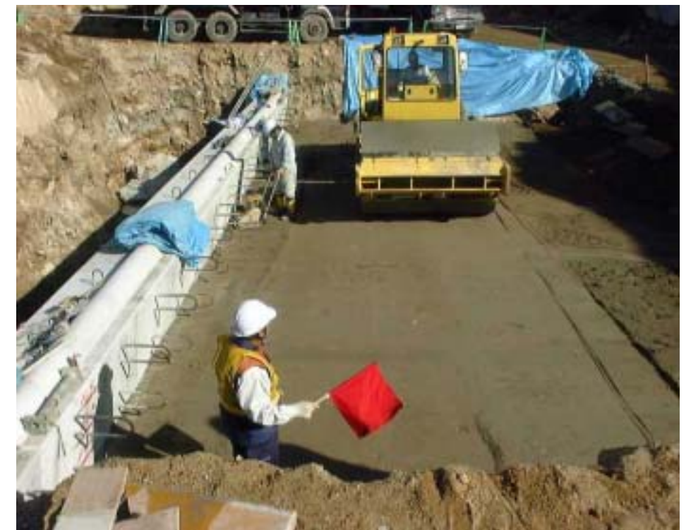
転圧作業状況
