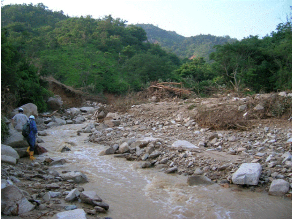
写真8 剣川の土砂の堆積状況
