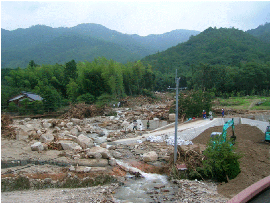
写真3 巨礫の堆積域の下流側(写真中央付近のコンクリートは農道) 老人ホーム屋上より撮影
