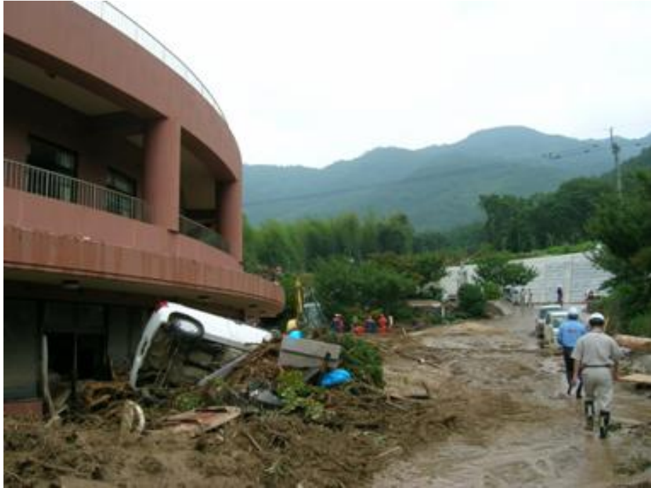
写真4 老人ホーム周辺の土砂堆積状況(土砂は細かい材料が大半)
