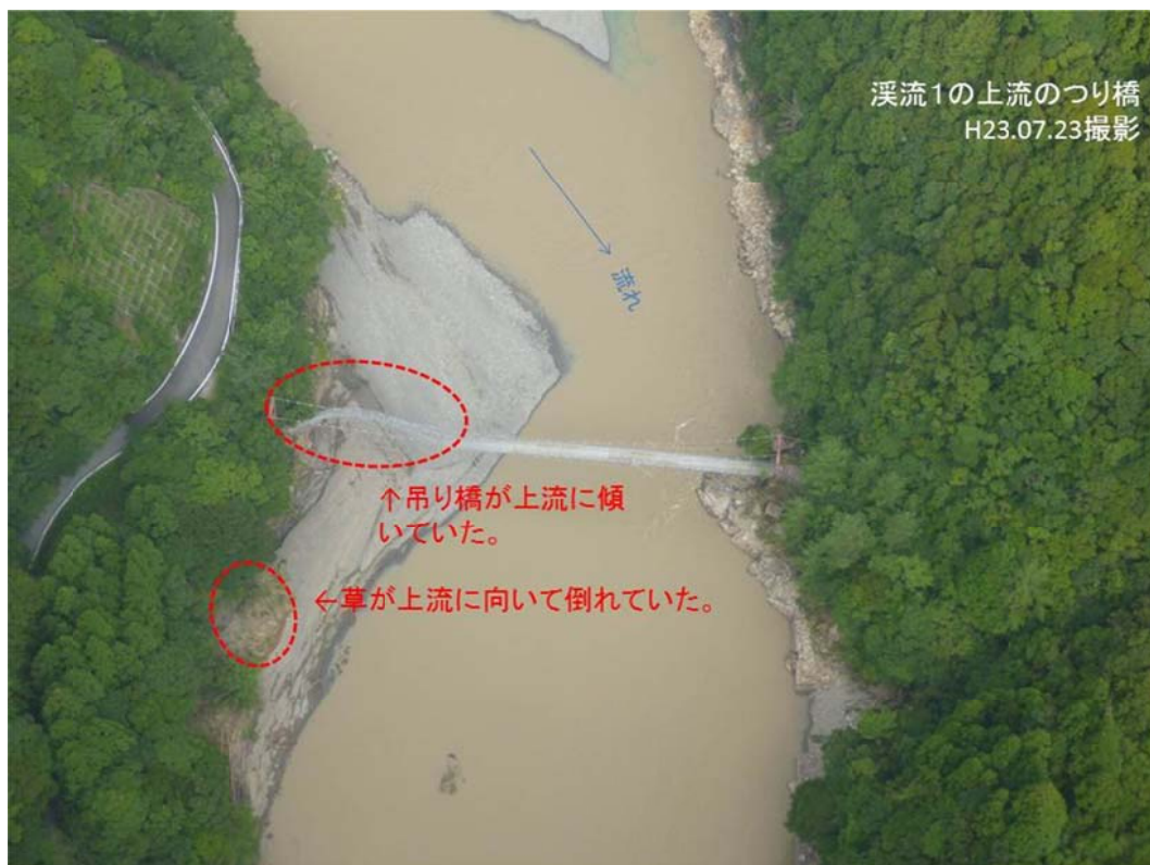
写真4 上流側吊橋の被災状況
