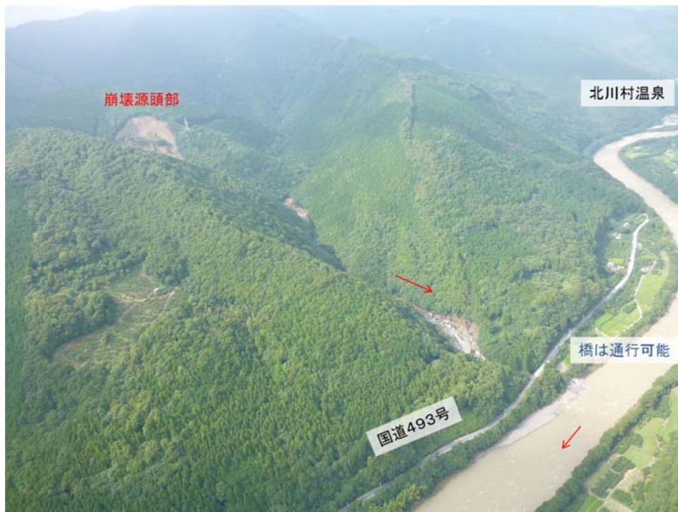
写真6 和田地区土石流の全景
