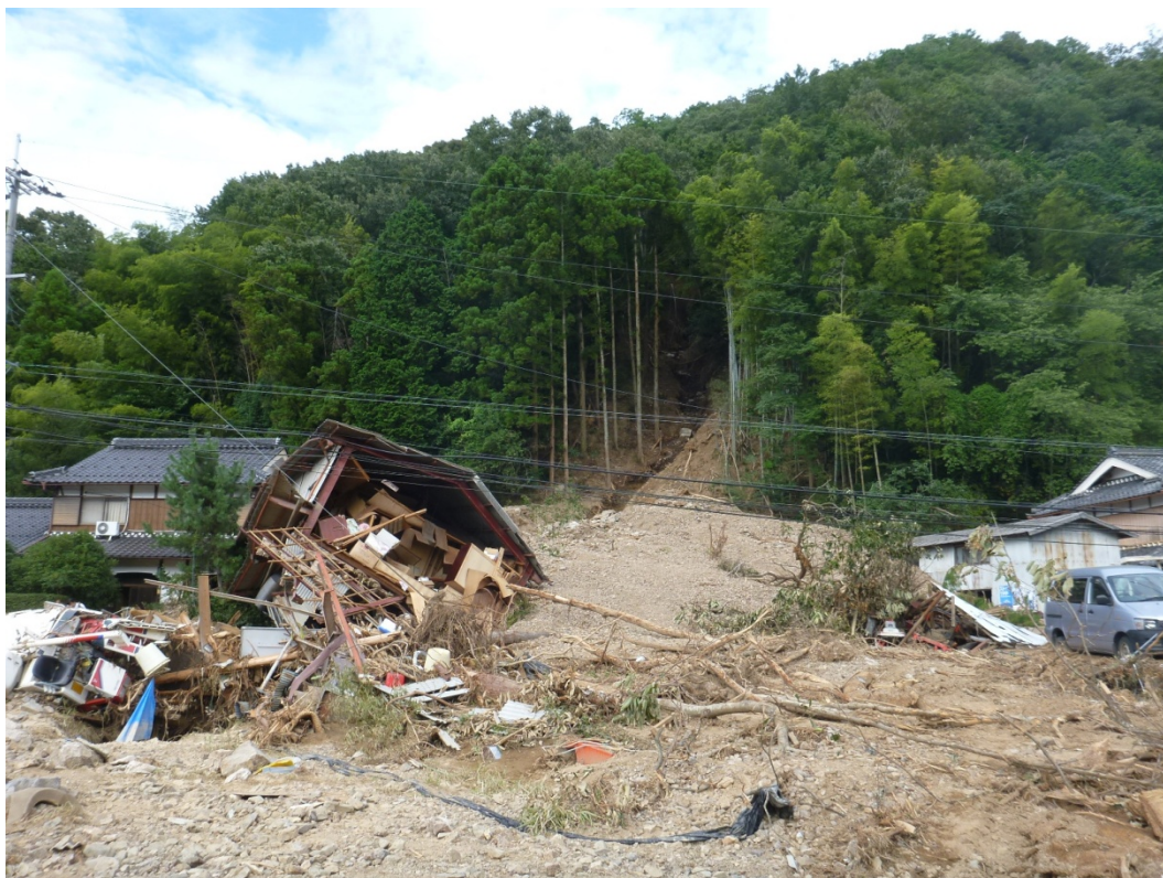
写真-5 ガリー下流の堆砂域と被害（徳尾地区 土⑦）
