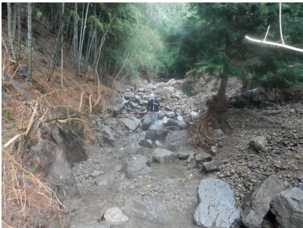
写真-20 堰堤上部の様子（大原谷川）
