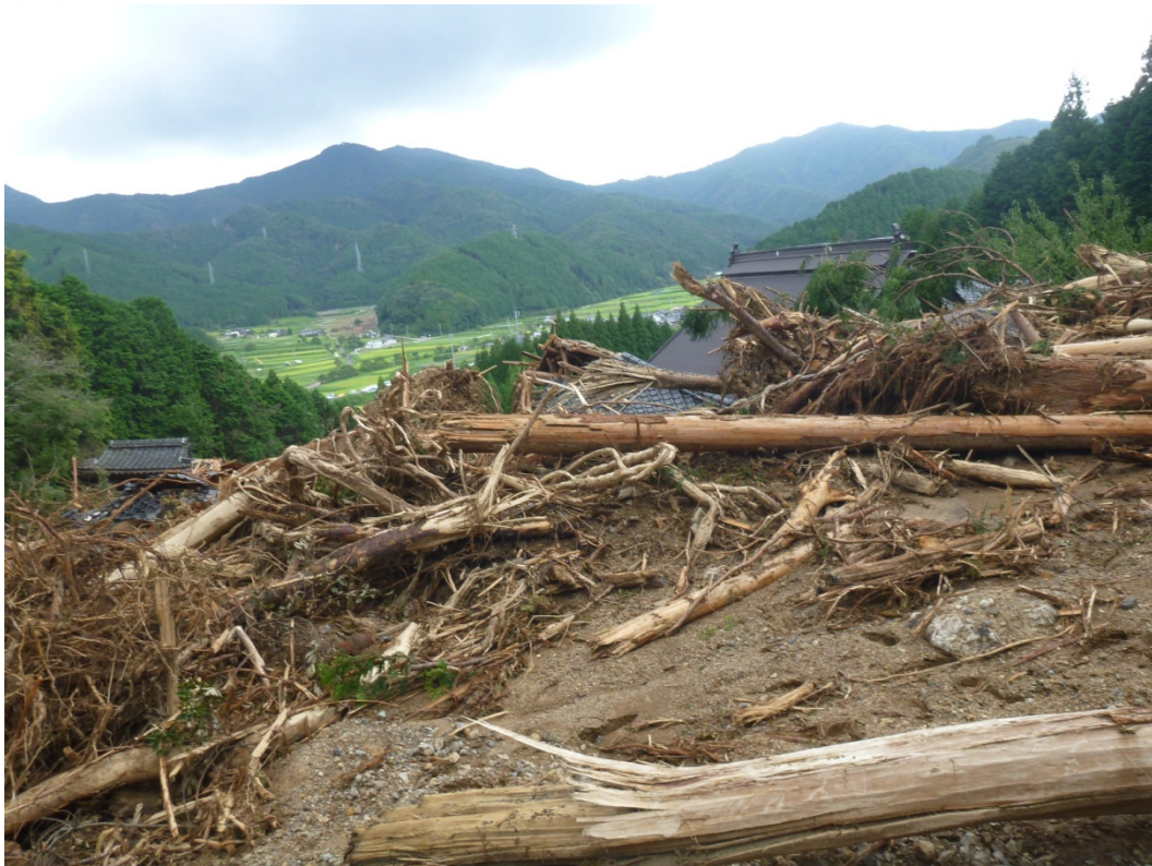
写真-14 東皐寺（中心やや右上に屋根）の上部の堆積状況（寺奥谷川）
