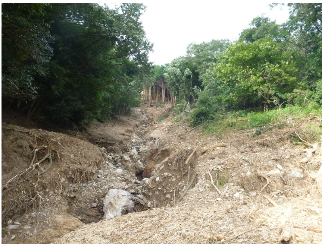
写真-7 侵食域の様子（徳尾地区 土①）
