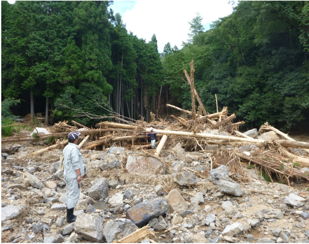
写真-3 堰堤の堆砂区間（深谷川）
