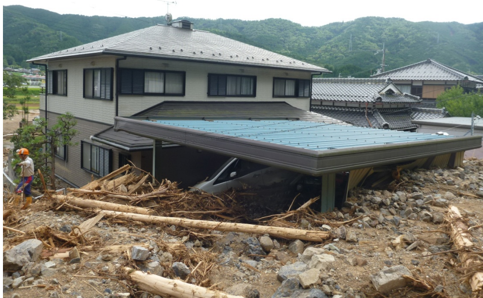
写真-2 家屋の損傷（深谷川）
