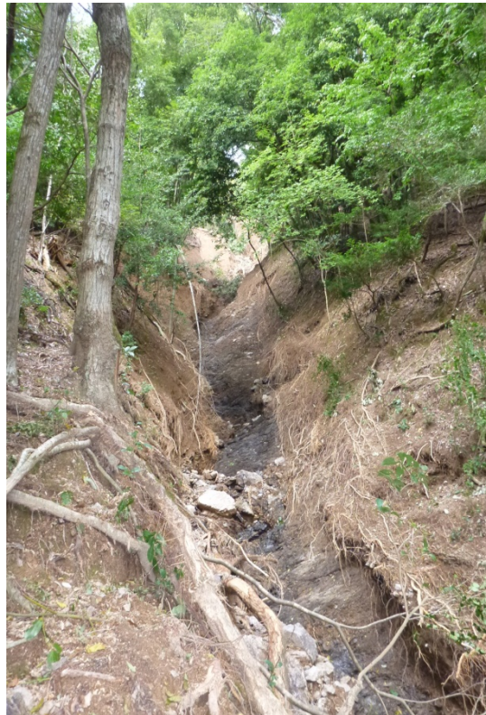
写真-4 ガリー（徳尾地区 土⑦）
