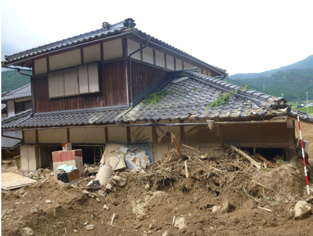
写真-12 合流点付近の家屋被害（寺奥谷川）
