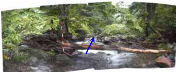
溪流内の所々に流木が引っかかっている状況
