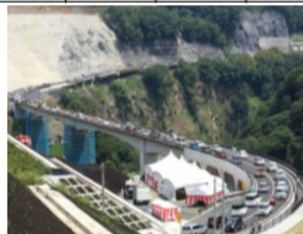
長陽大橋ルート 応急復旧 (H29/8/27)
