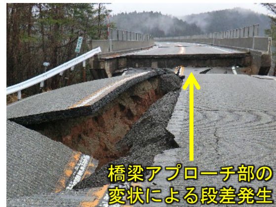
能越自動車道(のと里山海道)において被害の大きかった盛土の損傷
