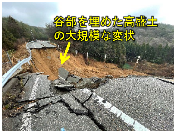
能越自動車道(のと里山海道)において被害の大きかった盛土の損傷
