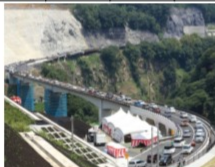
長陽大橋ルート 応急復旧 (H29/8/27)
