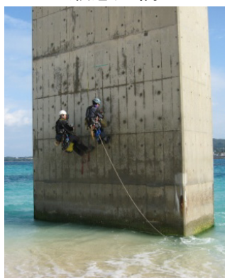
橋脚調査状況
