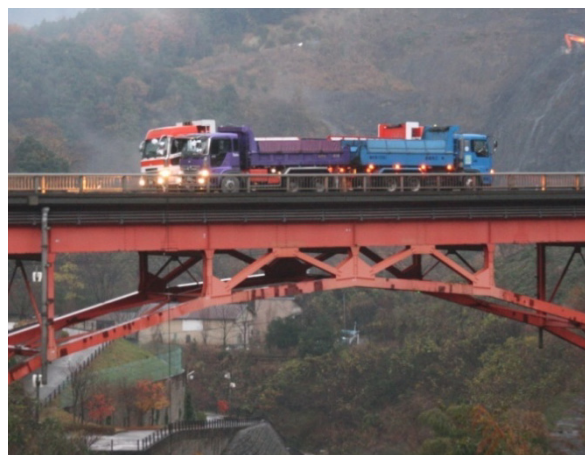
荷重車を用いた静的載荷試験
