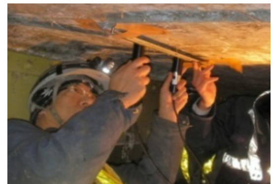
コンクリートの非破壊検査技術の適用性調査(超音波伝播速度測定)
