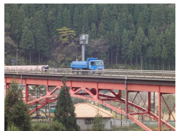
荷重車を用いた走行試験
