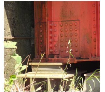
桁端部のあて板補強とゴム支承への取り替え(疲労対策)
