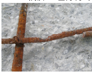
耐震補強工事時に鉄筋の腐食度を調査
