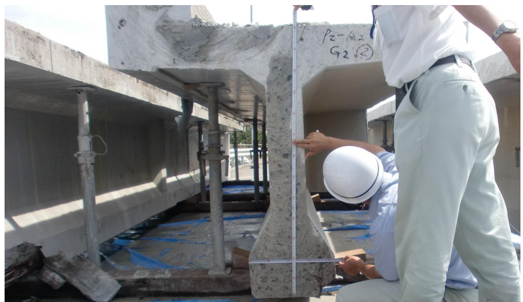
桁切断面の調査状況
