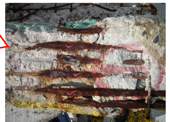
支承部の鉄筋
