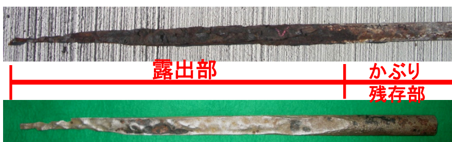
除錆前後の鉄筋状況
