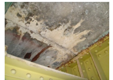
床版目地の漏水、遊離石灰
