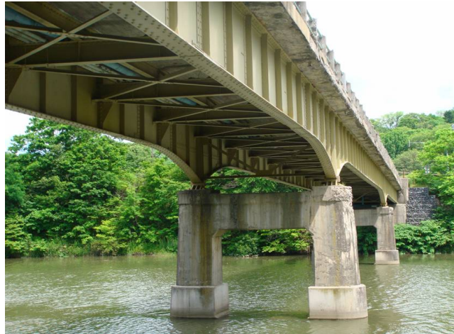
床版目地の漏水、遊離石灰
