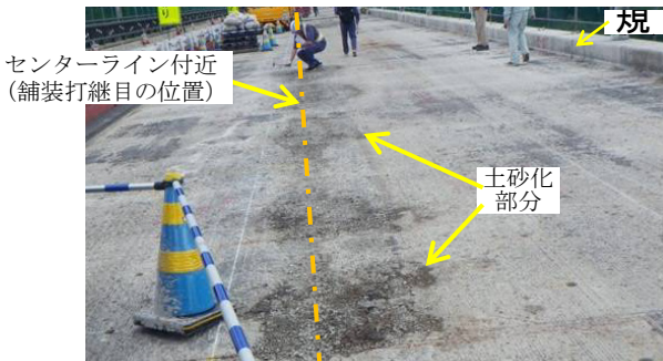
(a) 橋面アスファルト舗装を全面剥がした状況 1)
