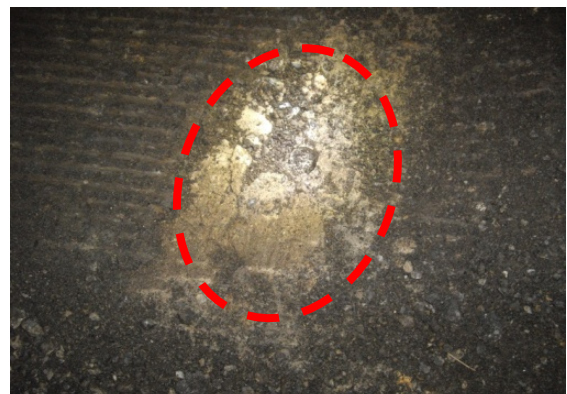
(a) 舗装を剥がした状況 1)
