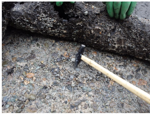
図-5 防水層下の土砂化の事例 (T 橋)
