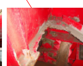
飯桁部端横桁
