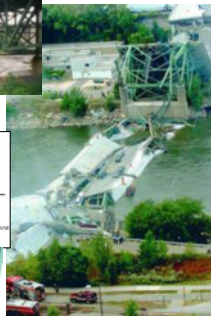
米国I-35W橋 トラス橋の崩落
