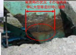
7号本荘大橋 トラス斜材の腐食・破断 (交通止め)
