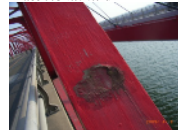
主構斜材（箱断面）
