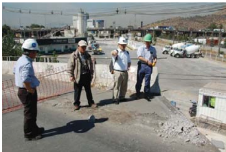
落橋した斜橋の状況調査
