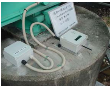
実橋脚を使って検証を行っている記憶型検知センサーによる地震被害予測システム
