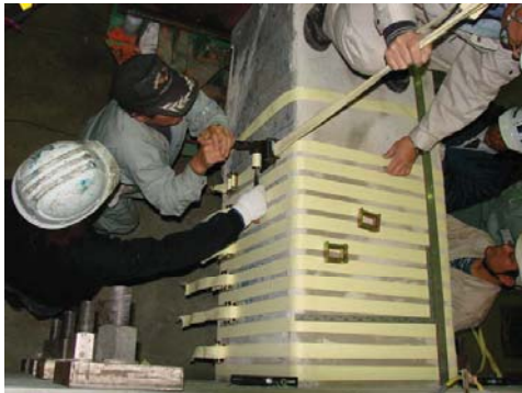
土木研究所CAESARで研究開発した機械式定着繊維バンドによるRC橋脚の応急復旧技術
