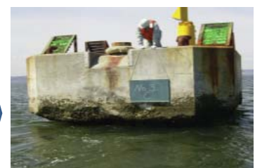
アイスブーム支柱の凍結融解と海水作用による摩耗
