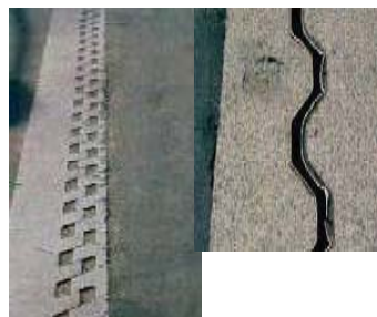
除雪作業に伴う伸縮装置の切削 傷や変形→本体へも衝撃作用
