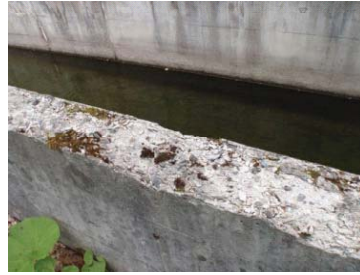
凍害による側壁天端のスケーリング
