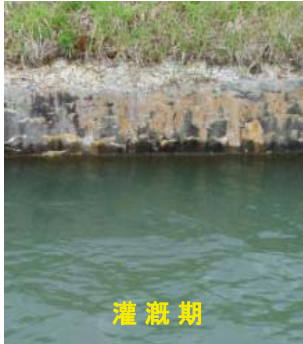
凍害による側壁天端のスケーリング
