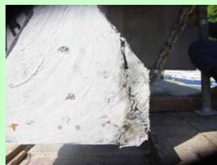
鋼材の配置、腐食状況
