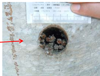
床版付近の曲げ上げ部でグラウト未充填部を確認
