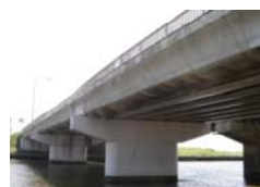
手前の主桁2本が撤去対象
