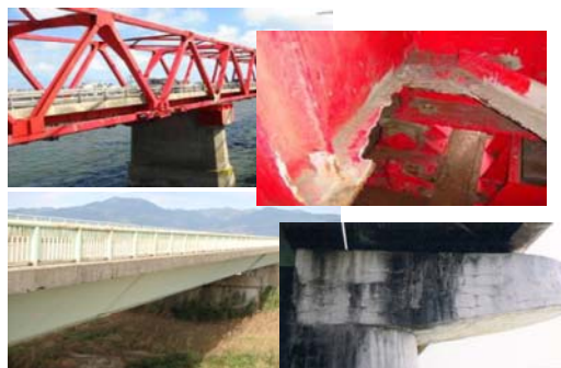
鋼材の配置、腐食状況
