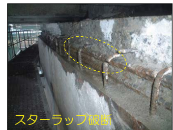
ASR(歌高架橋)
