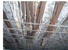
コンクリート橋におけるPC鋼線の破断
