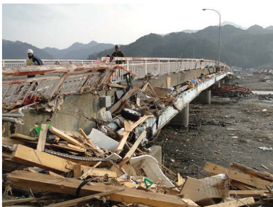
上部構造の高さにまで津波の遡上の痕跡があるが、流出していない橋
