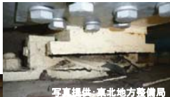
可動支承における 桁の振動跡
