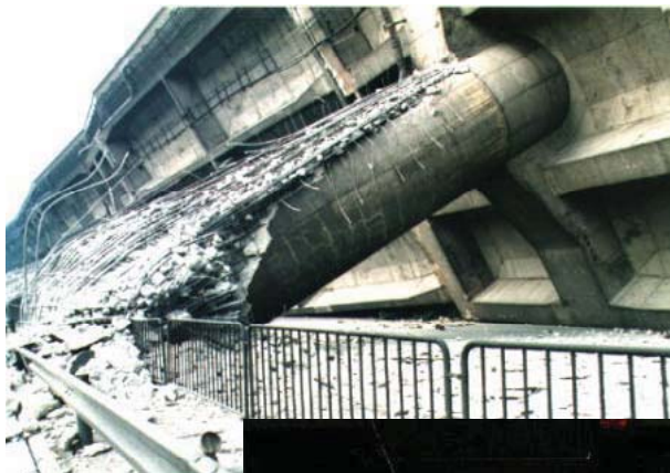
段落し部での損傷、破壊、倒壊
