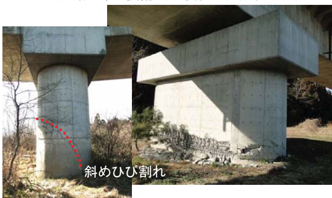
段落し部の損傷（地震後全面通行止め）
