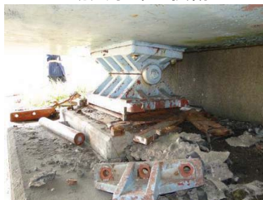
可動支承部の損傷
