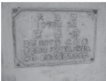
建造から37年経過 F11Tを使用
