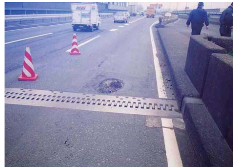
亀裂上の舗装に生じた変状
