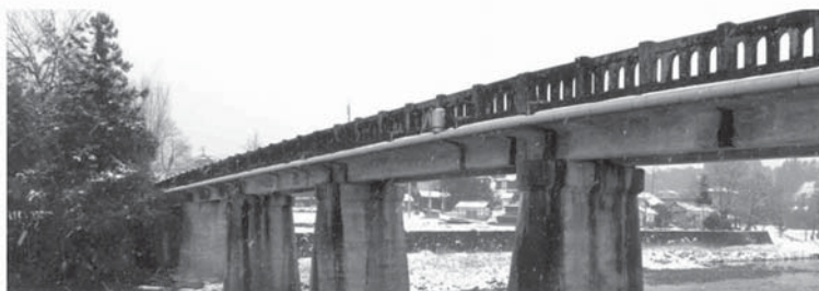
建造から76年経過 昭和11年
