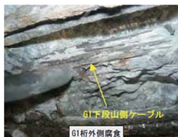
H21の調査で、PC鋼材の素線破断（8本のうち2本）
