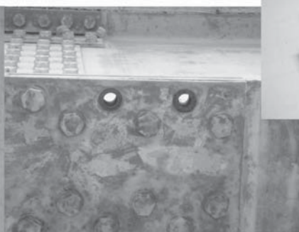
建造から37年経過 耐候性鋼材を使用
