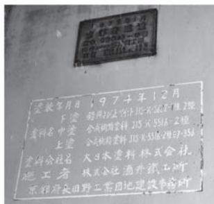
建造から37年経過 耐候性鋼材を使用
