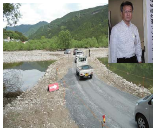
河川内緊急通路
