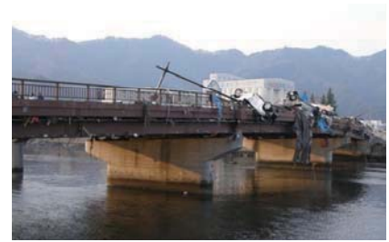
橋桁が流出しなかった橋
