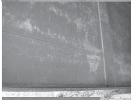
建造から37年経過 耐候性鋼材を使用
