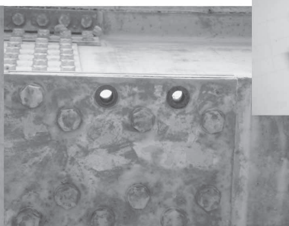
建造から37年経過 耐候性鋼材を使用
