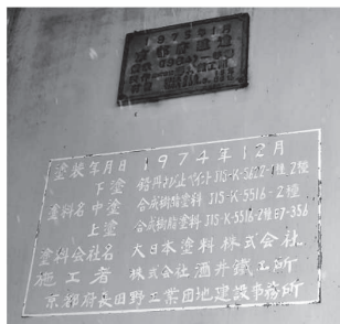
建造から37年経過 耐候性鋼材を使用
