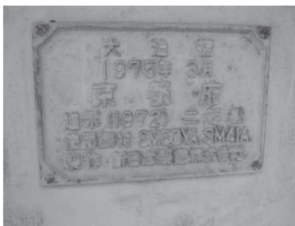
建造から37年経過 F11Tを使用
