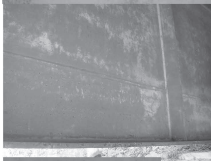
建造から37年経過 耐候性鋼材を使用
