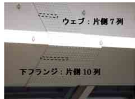
多列ボルト継手の適用事例
