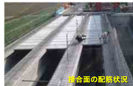
従来規定による合成桁接合面の配筋例
