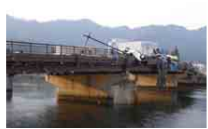
橋桁が流出しなかった橋
