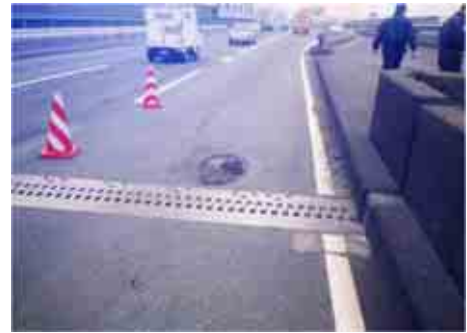
亀裂上の舗装に生じた変状
