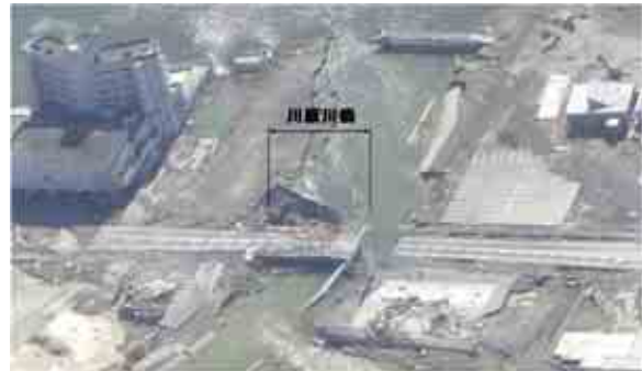
川原川橋の例
