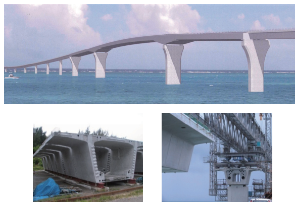
新設橋(伊良部大橋)
