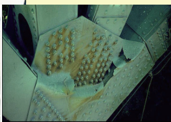
直上のジョイントからの漏水に伴う断面欠損による座屈
