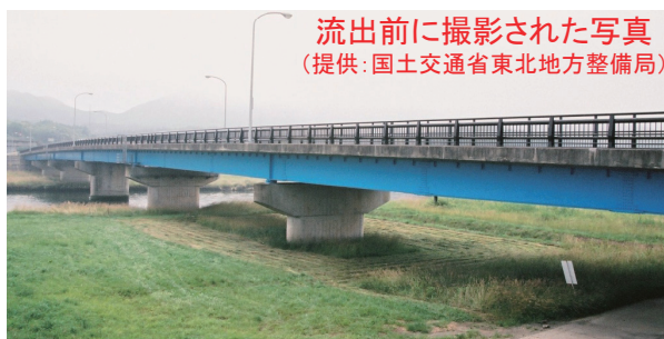
津波により橋桁が流出した小泉大橋 (気仙沼市)
