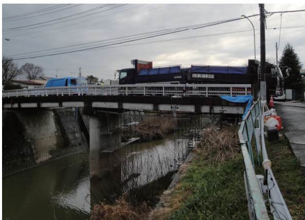
載荷状況 (第2径間)
