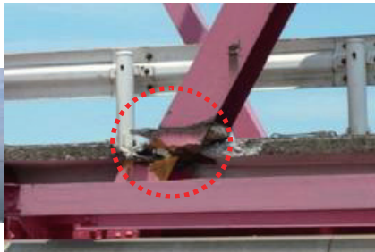
トラス橋の斜材の腐食・破断(2007年6月)
