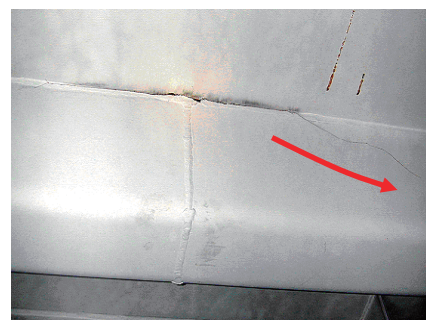
溶接に沿って長く進展したき裂(ビード進展き裂)
