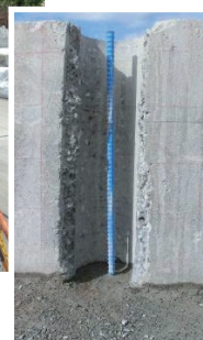
はつり出したエポキシ樹脂鉄筋
