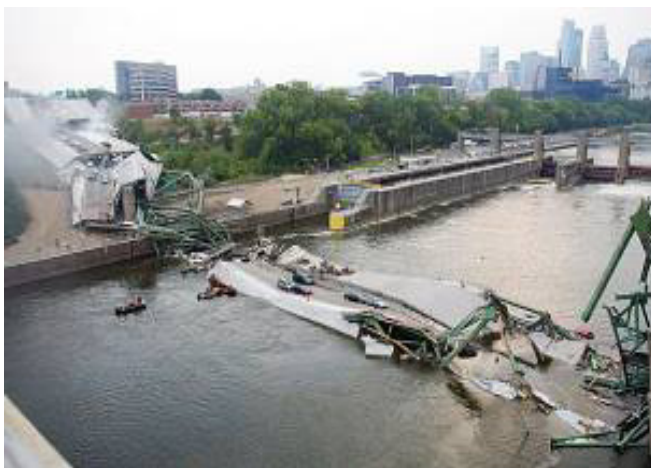
鋼トラス橋の崩落(2007年, 米国)
