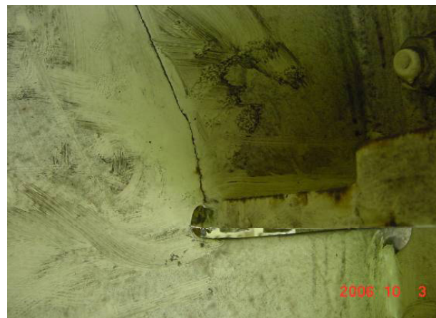
鋼げた橋のき裂(2006年, 国道25号山添橋)
