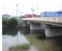
写真-1 稲村橋全景
