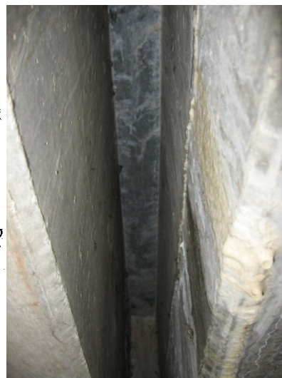
桁間での漏水
