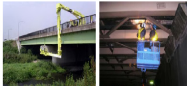
橋梁点検車を使った橋梁点検
