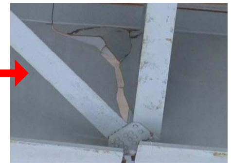
海外の桁破断事例(米国、2000年)
