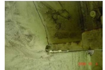
鋼 I 桁橋の桁破断事例 (2006年)
