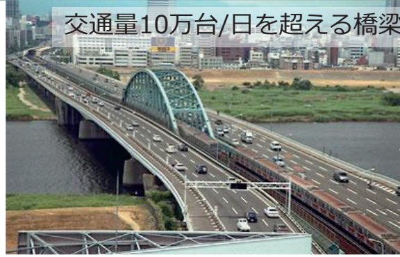
新御堂筋線高架橋
