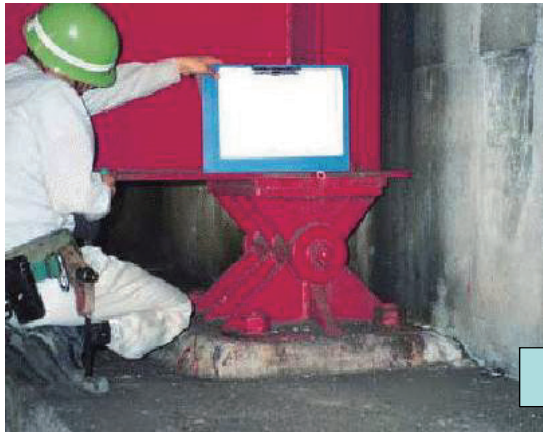
取替え前（鋼製支承）
