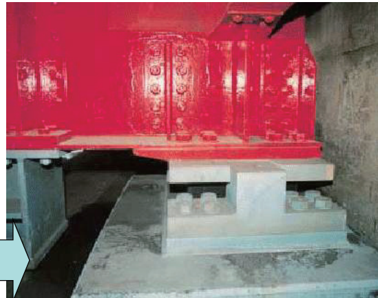
取替え完了（ゴム支承）
