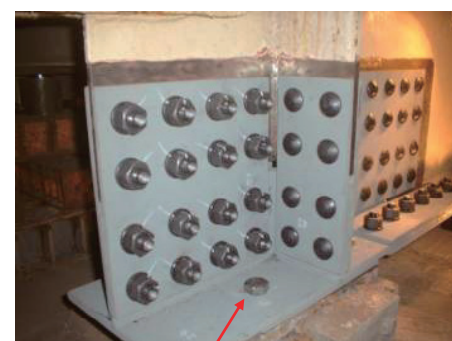
沓のセットボルトは、タップを切り直す
