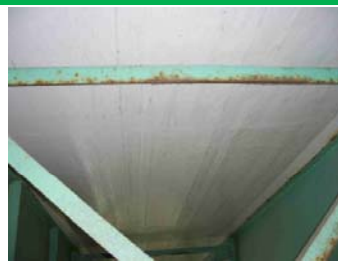
一般的なCFRPシート補強
