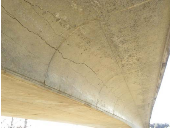
PC桁の水平ひび割れ
