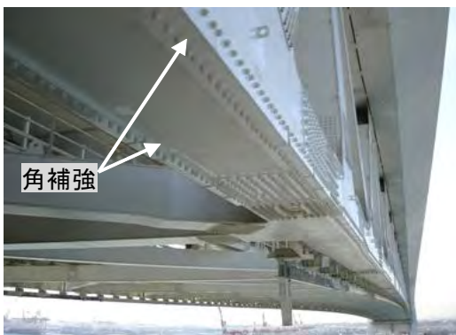
横浜ベイブリッジのトラス部の耐震補強
