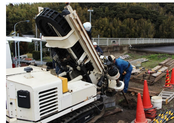
杭間地盤調査の状況
