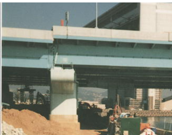
液状化に伴う側方流動による 橋脚・橋台の損傷
