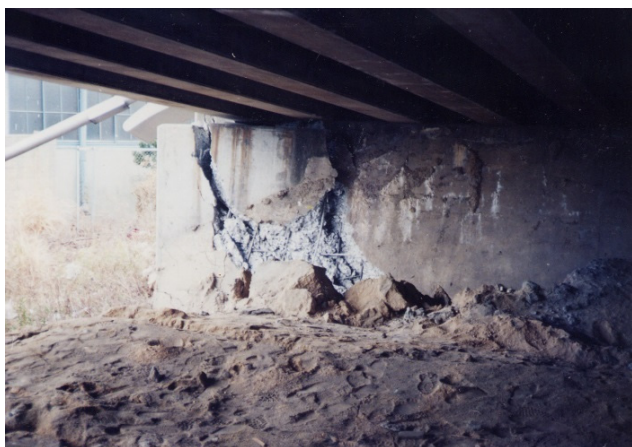
液状化に伴う側方流動による 橋脚・橋台の損傷
