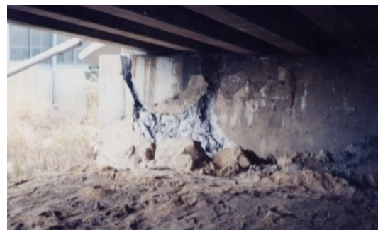
長期通行止めが生じた橋の損傷
