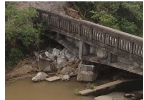
写真-3 左岸側橋脚
