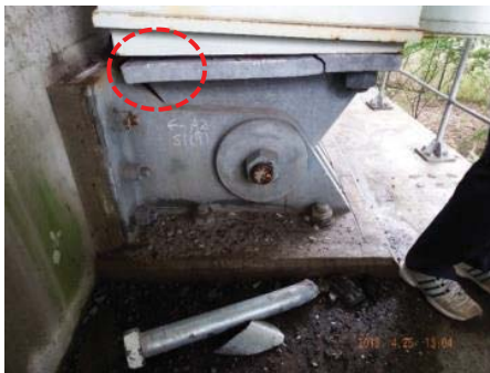
写真-1 取付けボルトの抜け出し、橋台背面の損傷(並柳橋)
