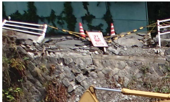
写真-2 右岸側橋台上部
