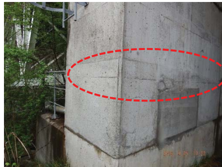
写真-1 取付けボルトの抜け出し、橋台背面の損傷(並柳橋)
