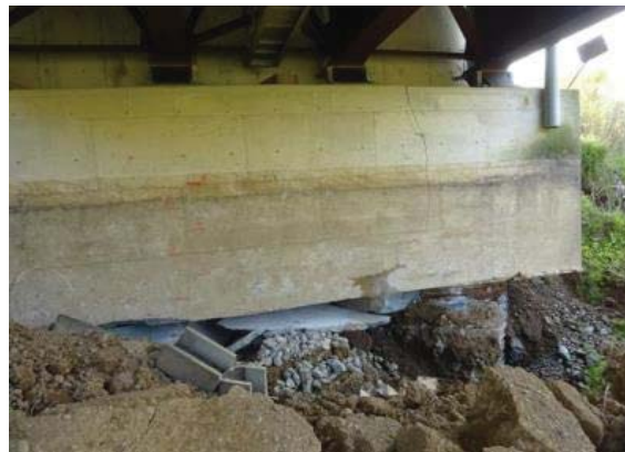
写真-2 橋台周辺での地盤 変状による橋台の沈下 (県道熊本高森線・俵山大橋)
