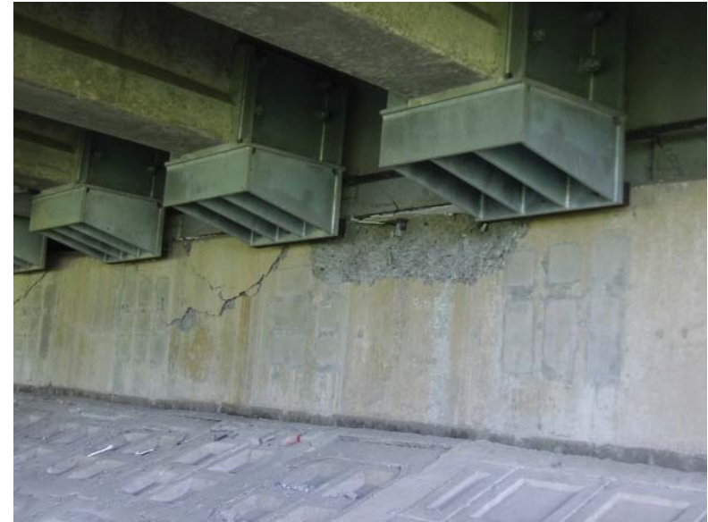
写真2 橋台の損傷
