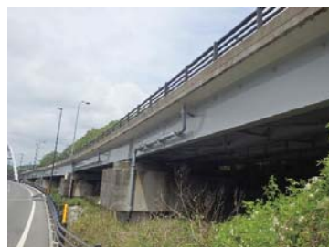
あそぐち 写真-2 阿蘇口大橋 (国道57号)
