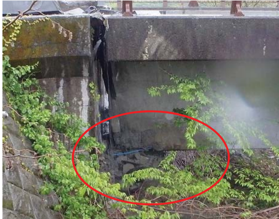
写真-1 橋梁周辺での大規模な斜面崩壊(上) A2橋台側桁端部の損傷(下) (村道栃の木～立野線・阿蘇長陽大橋)
