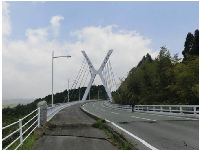
写真-1 桑鶴大橋の全景(A1側から)
