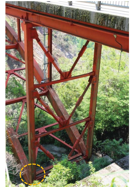
写真-2 座屈拘束ブレースが取り付けられた端柱基部のボルトの破損(南阿蘇橋)
