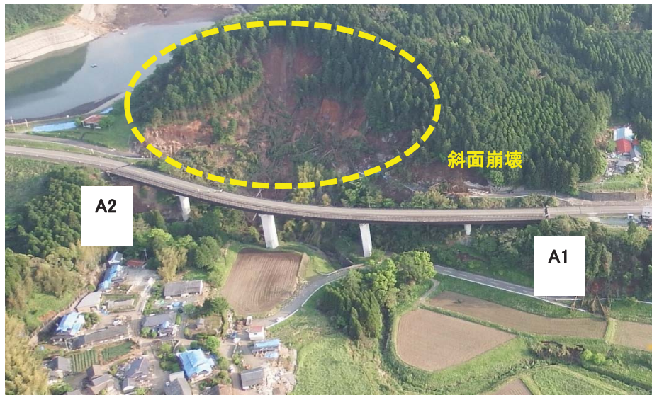
写真-1 大切畑大橋全景
