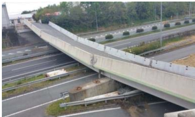
県道小川嘉島線 府領第一橋
