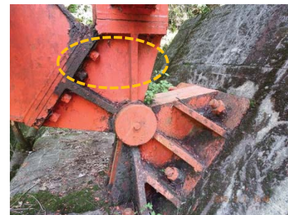
写真-2 座屈拘束ブレースが取り付けられた端柱基部のボルトの破損(南阿蘇橋)
