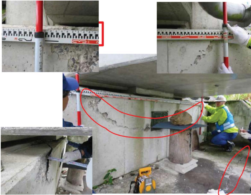
写真1 橋台の損傷
