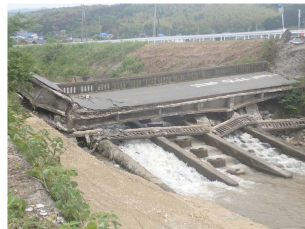
町道平田・小柳線 田中橋
