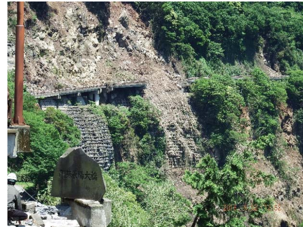
村道栃の木～立野線 戸下大橋
