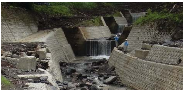
村道獄大道・吉岡線 宇曾谷橋
