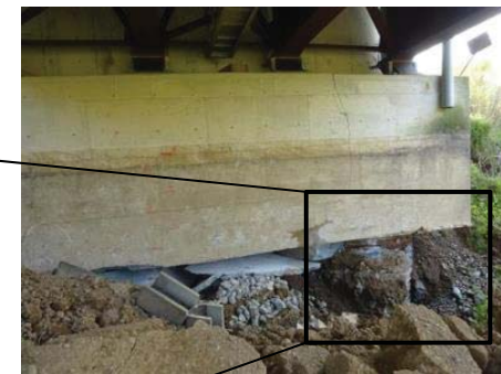
写真-3 A1橋台の基礎の露出
