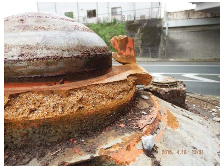
写真-3 ピボット支承(下沓拡大)
