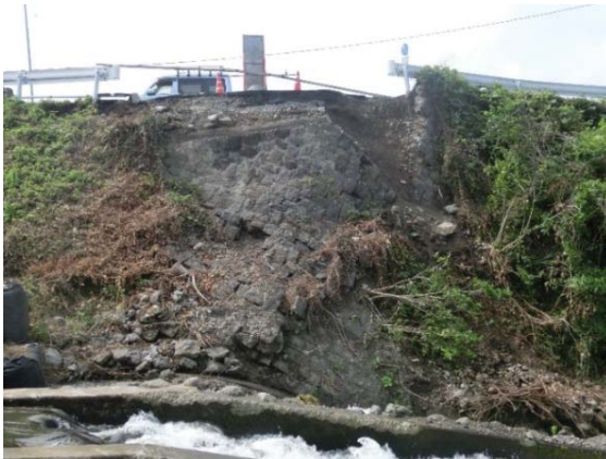
写真-1 左岸側橋台
