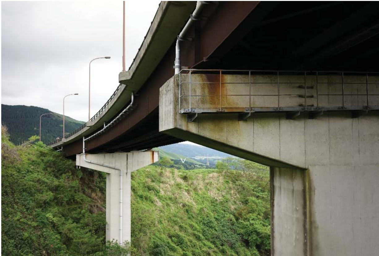
写真-1 扇の坂橋
