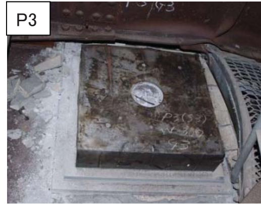
写真-1 ゴム支承の損傷状態
