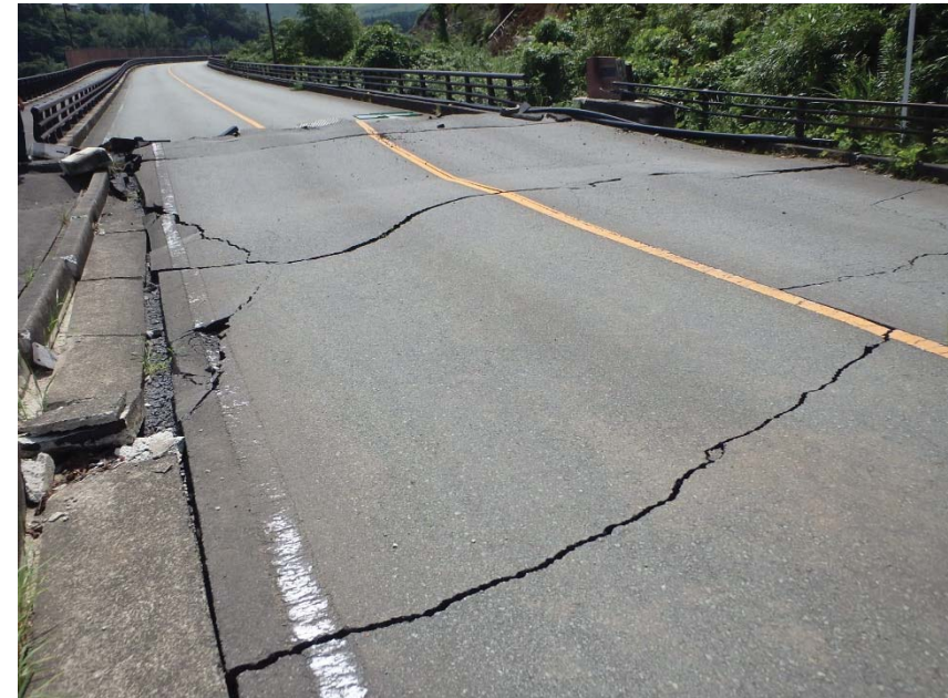
写真-2 大切畑大橋(A1側から)
