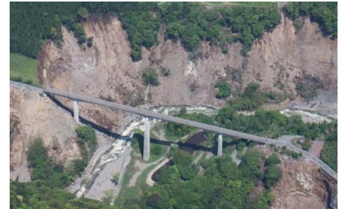
村道柵の木～立野線 阿蘇長陽大橋
