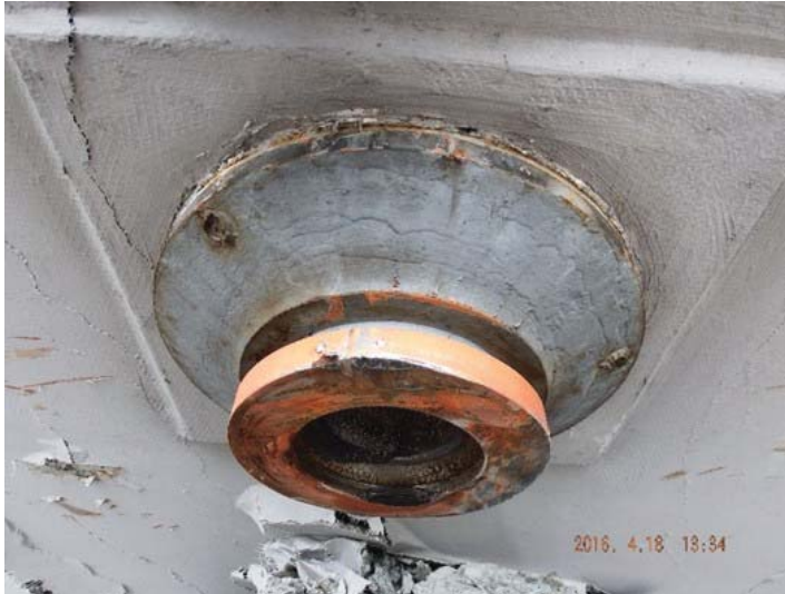
写真-1 ピボット支承(上沓)
