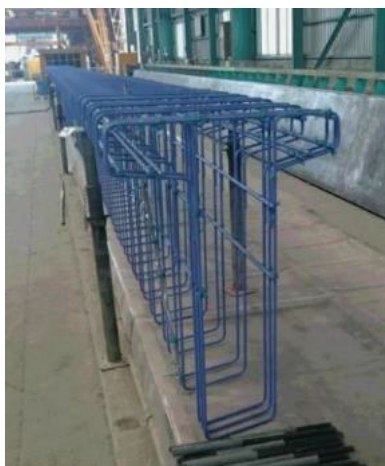
防錆鉄筋の 組み立て状況
