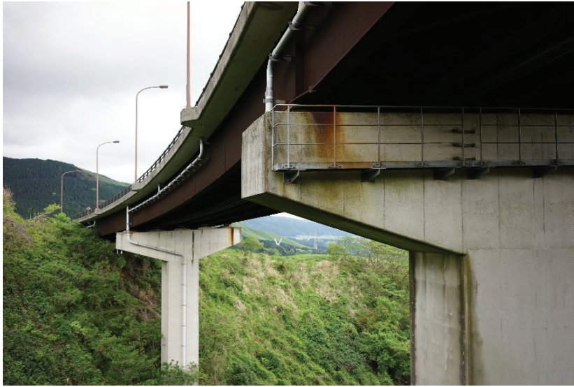
写真-1 扇の坂橋
