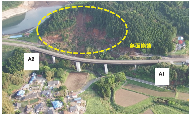
写真-1 大切畑大橋全景
