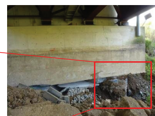
写真-3 A1橋台の基礎の露出
