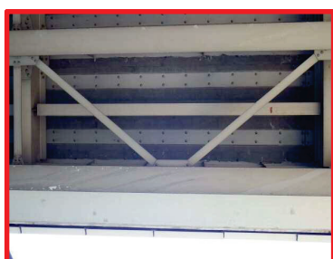
R C床版下面状況
