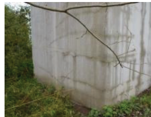
写真-5 P2橋脚のひび割れ
