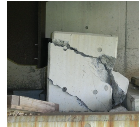
写真-3 A1橋台の横変 位拘束構造の損傷
