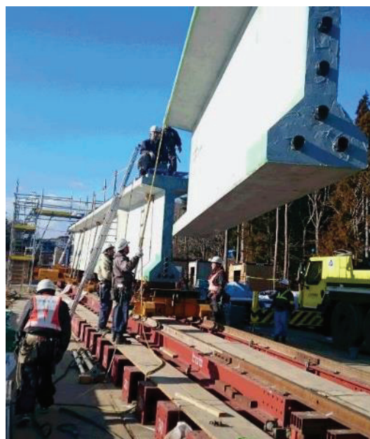
主桁の接合状況
