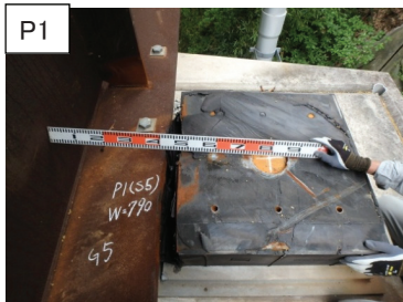
取り付けボルトが破断
