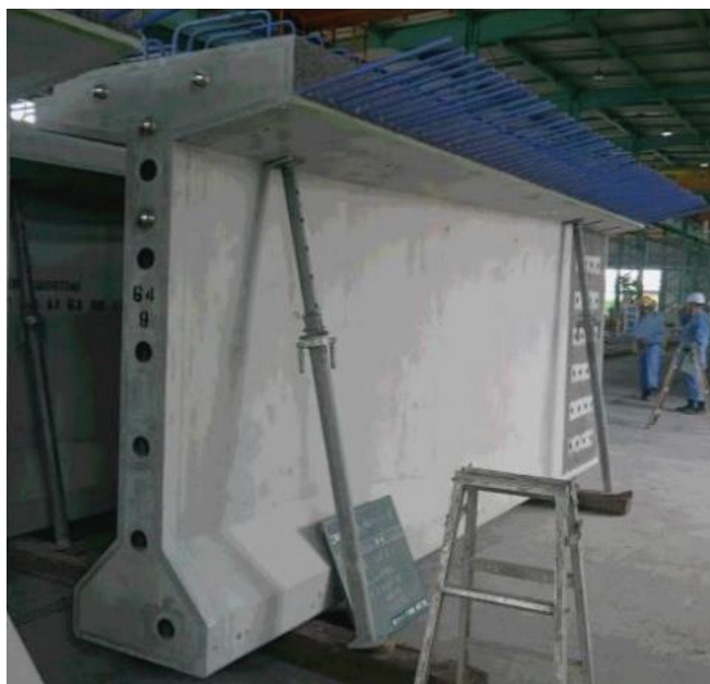
桁の仮置き状況
