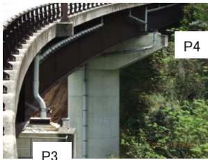
写真-3 桁の残留変位
