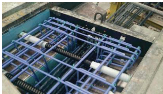
PC鋼線も防錆仕様 シースはPEシース
