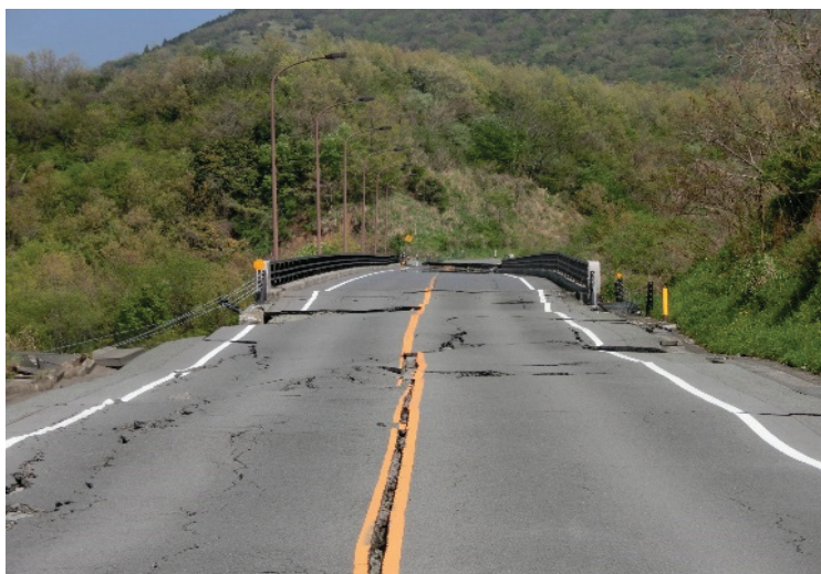
写真-1 A1橋台背面側からの全景
