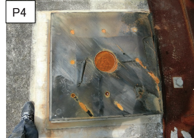
ゴム部分又は接着層が破断
