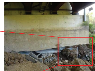
写真-3 A1橋台の基礎の露出
