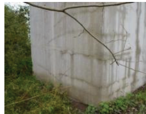
写真-5 P2橋脚のひび割れ
