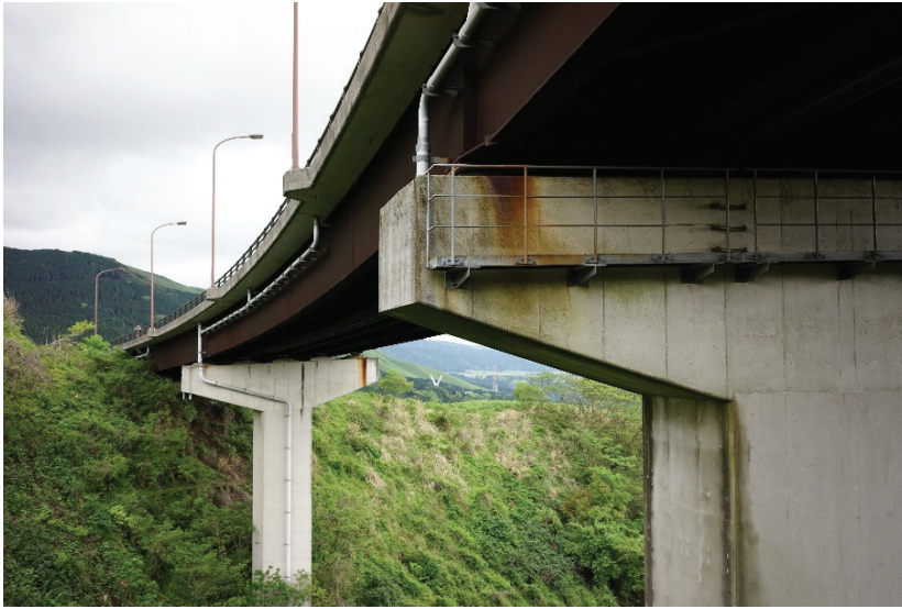
写真-1 扇の坂橋
