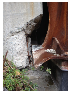
写真-5 A2橋台の損傷、G1支承の橋座からの逸脱
