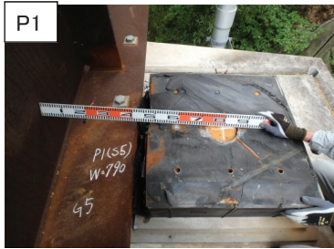
取り付けボルトが破断
