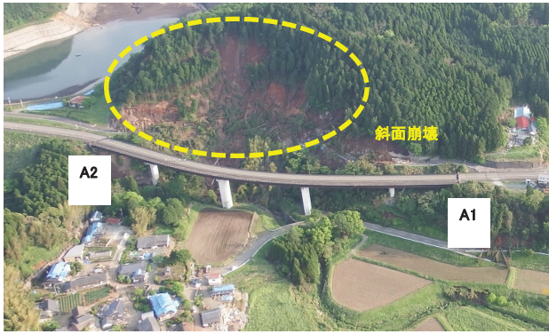
写真-1 大切畑大橋全景
