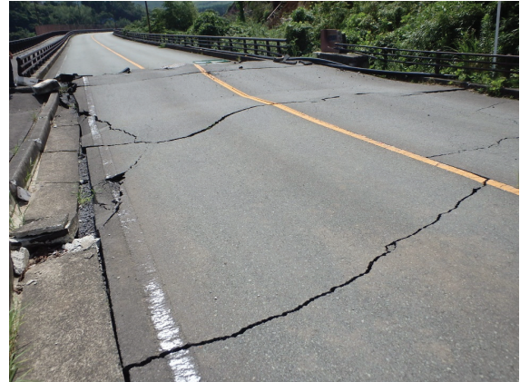
写真-2 大切畑大橋(A1側から)
