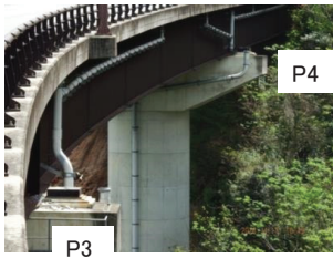
写真-3 桁の残留変位
