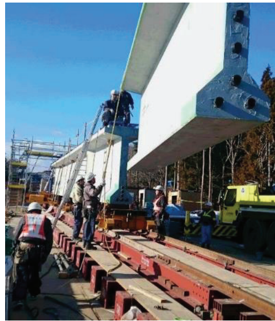
主桁の接合状況
