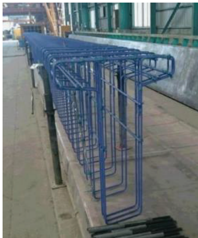
防錆鉄筋の 組み立て状況
