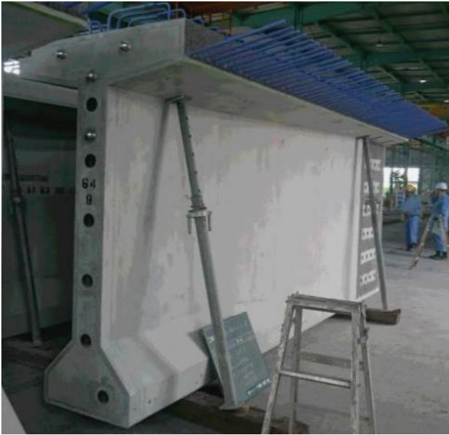
桁の仮置き状況
