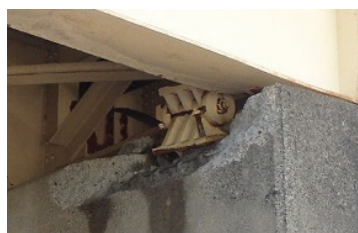
橋座コンクリートの損傷
