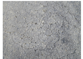
路面に亀甲状ひび割れがある
