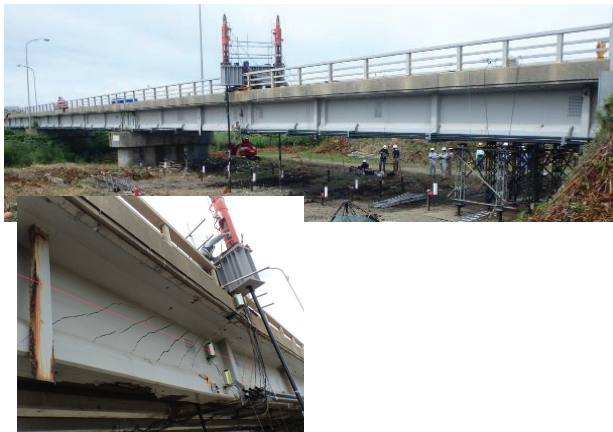
国内初の実橋主桁の破壊試験（北海道）
