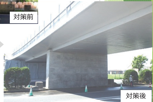
耐震補強の施工例（国交省HP）
