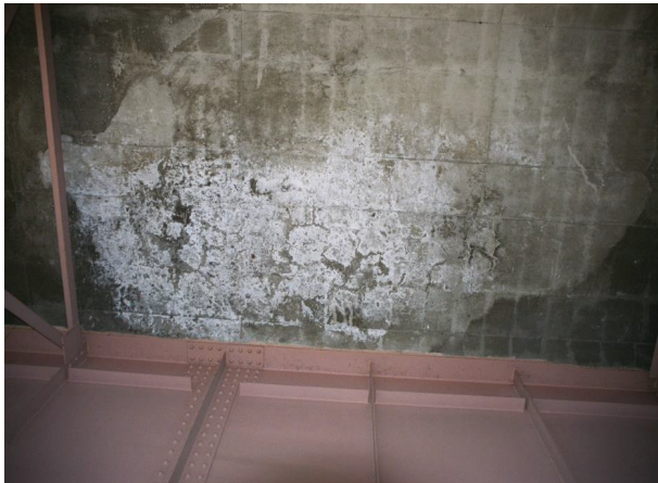
A橋のRC床版下面状況
