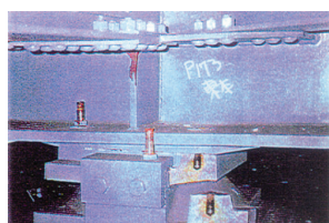
上沓ストッパー部の破損
