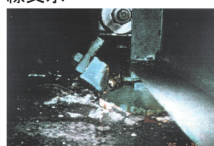
移動制限装置(下沓の凸部)の破断
